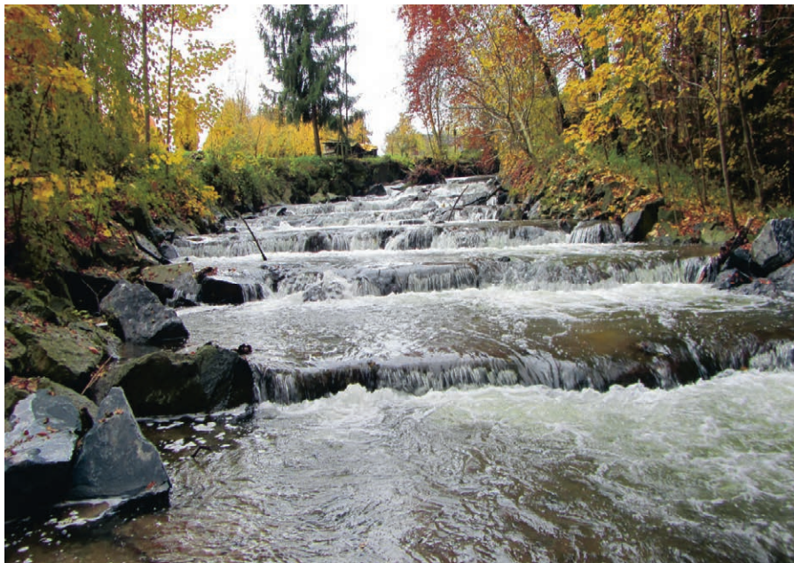
Fischtreppe Hütten: Bild von Walter Kradolfer
